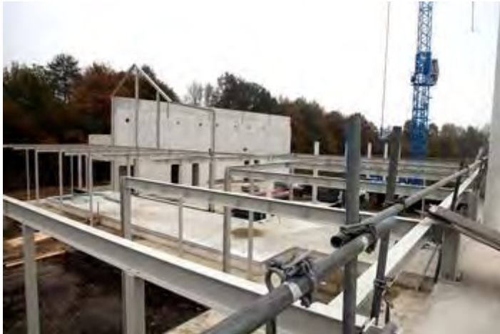
De bouw van het speelleercentrum is in volle gang
