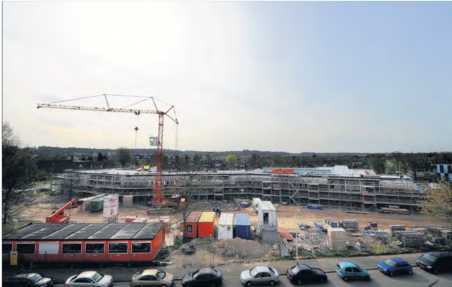
De bouw van de Talentencampus aan de Rijnbeekstraat/Laaghuisingel
