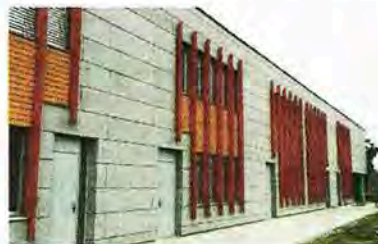
De gevel van de school heeft geen lekken. Uit de ventilatielucht komt 90 procent van de warmte.
